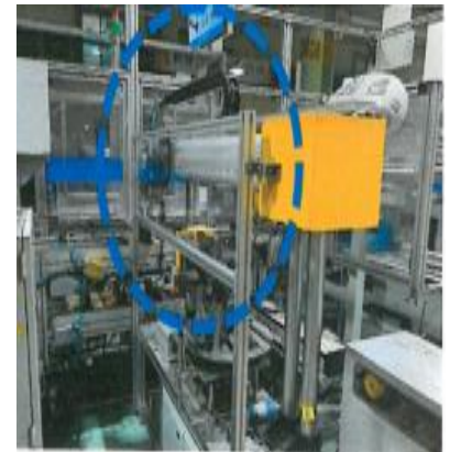
겐트리 로더 충돌방지 방호커버 설치
